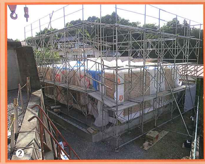
U & U工法の施工手順。工場生産されたユニットを積み上げて住宅をつくる。
